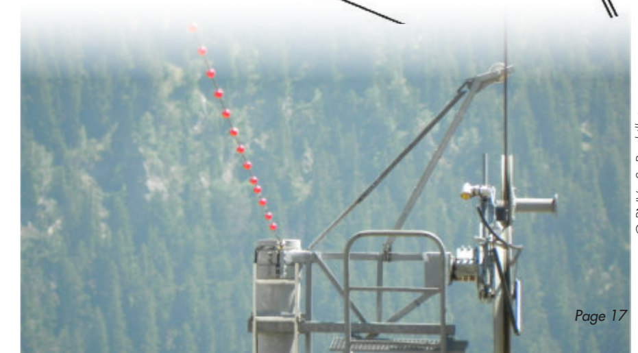
▼ Un télésiège équipé de flotteurs installés sur la cordeline.
