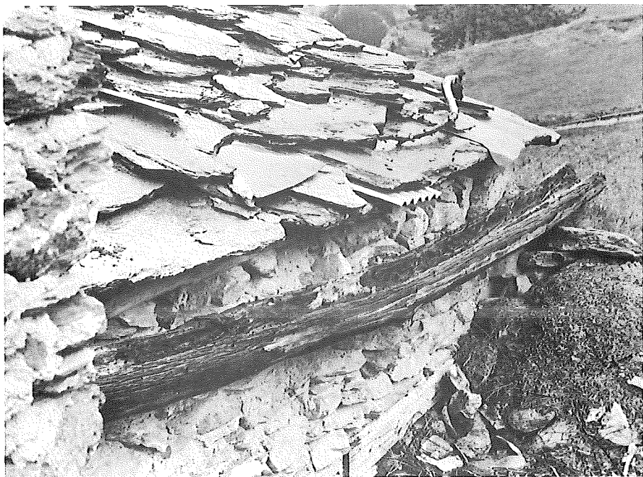
PHOTO 3. — Toit de lauze et gouttière en Mélèze dans la vallée du Planey.
