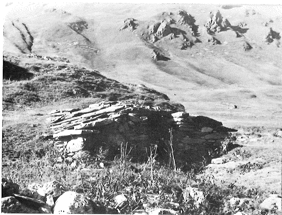
PHOTO 6. — Cave à lait à demi enterrée.
