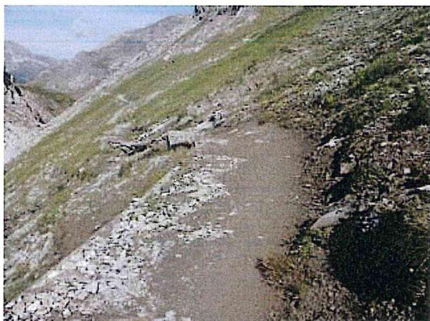
Troisième zone (5 mètres linéaires): réfection complète des gabions, ramener la largeur de la plate forme à un mètre
