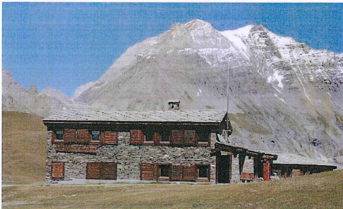
Façade sud avant travaux :
