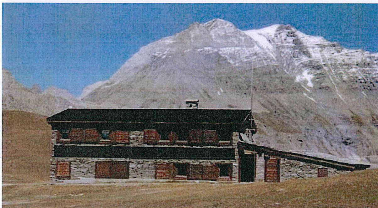
Façade sud après travaux :
